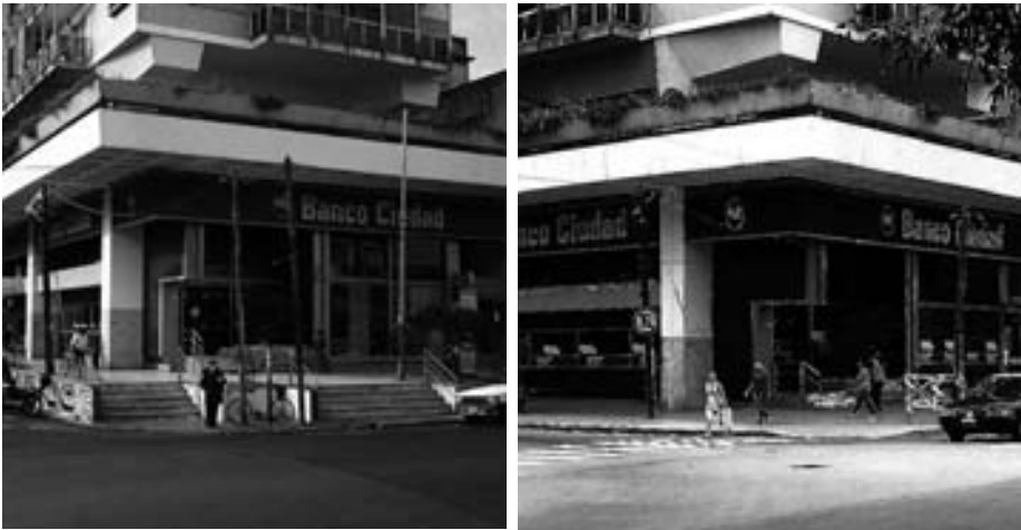
ANTES Y DESPUES. Sin escaleras, la esquina de Suárez cambió su fisonomía.
