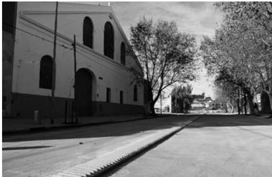
DE PUNTA A PUNTA. Las obras llegaron hasta donde Patricios se hace Riachuelo.
